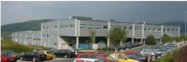
Il nuovo edificio per la di produzione costruito nel 2003
